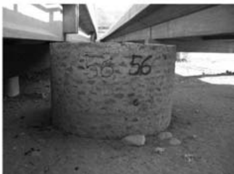
صورة رقم (٤) تظهر الخرزة رقم (٥٦) وقد صعب الكوبري المنشأ فوقها دخولها من أعلى للتطهير أو الصيانة (تعديلات قطاع عام)
